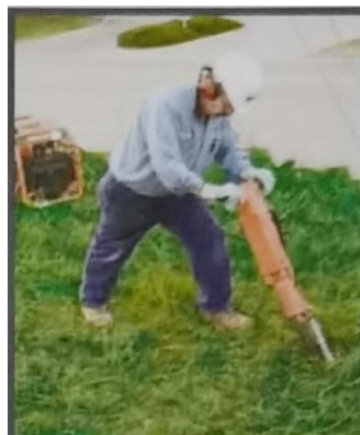
3、通过延长打射导杆将地锚打入到合适的深度
