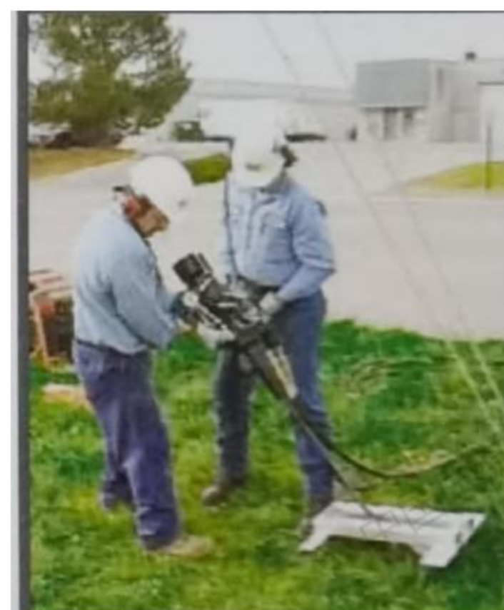
6、将转向棒接入地锚拉缸末端，将轻便的液压系统和上拔器就位，将转向棒接入上拔设备
