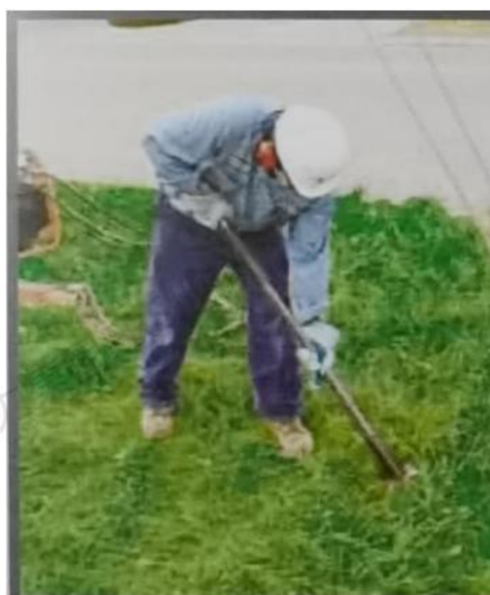
4、施工员将打射导杆从土壤中拔出
