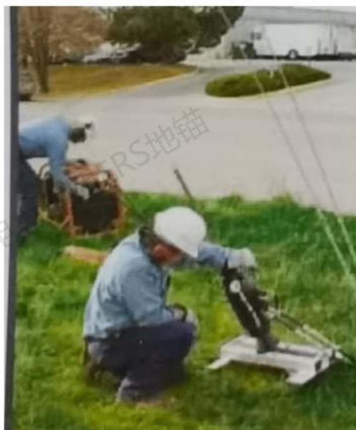
7、便携式的动力站带动上拔器，上拔器紧夹并上拔转向棒，转向棒带动地锚旋转并固定于土壤中上拔器的液压表上即时显示锚固力
