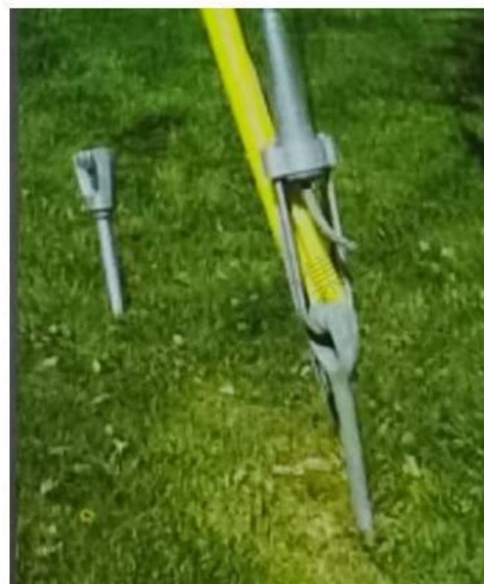
8、移走上拔器，将调整螺母安装到位拉杆末端，即可拉线
