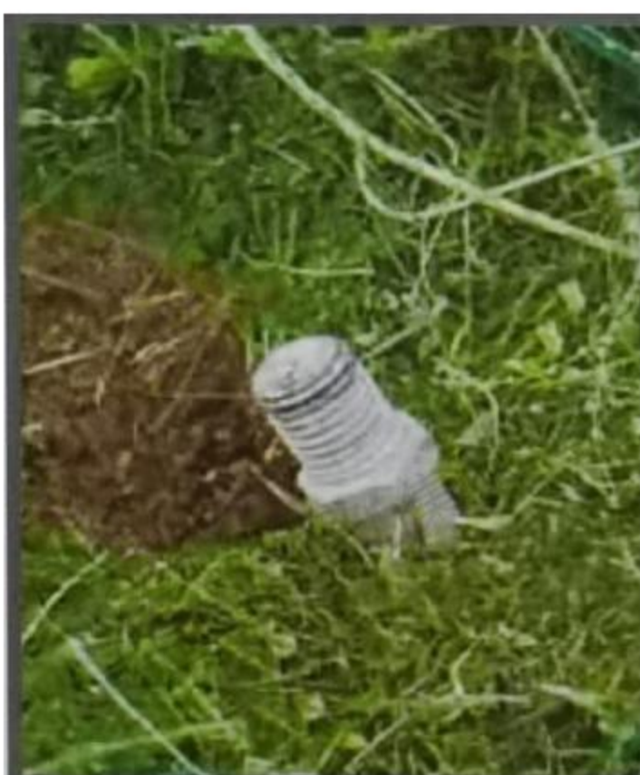
5、地锚拉杆末端与地面平行，而在较松软的土壤施工时，可将末端低于地面30厘米，以获取更大的拉力
