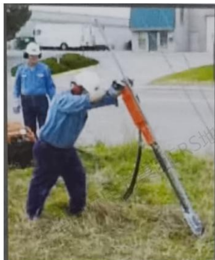
2、把打射导杆插入地锚导孔内，选好角度，定位
